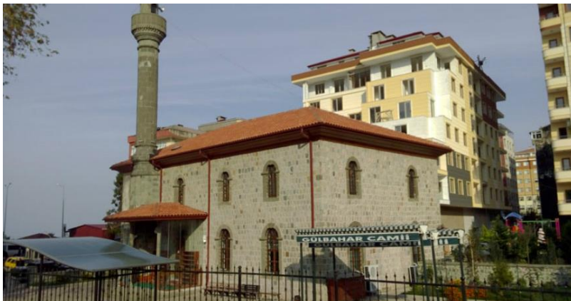
Şəkil 4. Rizedə yerləşən Böyük Gülbahar məscidinin ümumi görünüşü
